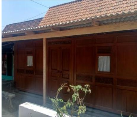
Gambar 14 : Material alami kayu pembentuk elemen dinding bangunan
