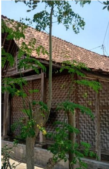
Gambar 15 : Material anyaman bambu pembentuk elemen dinding bangunan
