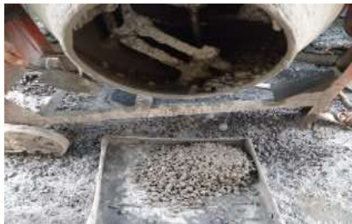
Gambar 4. 4 Menuangkan Campuran Beton Ke Wadah
