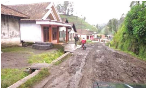
Gambar 30: Kondisi jalan di Desa Wisata Ranu Pani
