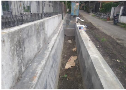
Gambar 1. Saluran drainase pada saat pembangunan
