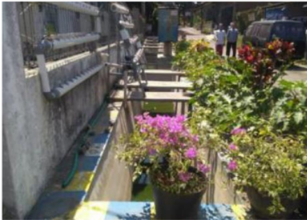
Gambar 2. Saluran drainase yang dimodifikasi untuk budidaya ikan dan sayuran
