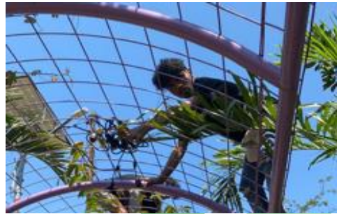
Gambar. 3 Proses pemasangan lampu penerangan jalan
