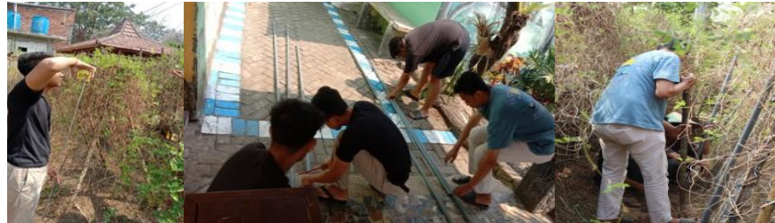
Gambar. 8 Proses pemasangan rangka media tanam dan water timer
