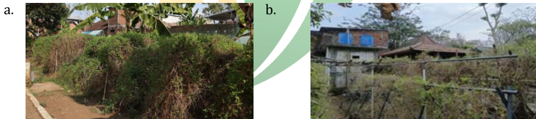
Gambar. 9 (a) Sebelum pemasangan rangka baru dan alat water timer ; (b) Hasil setelah pemasangan rangka baru dan alat water timer
