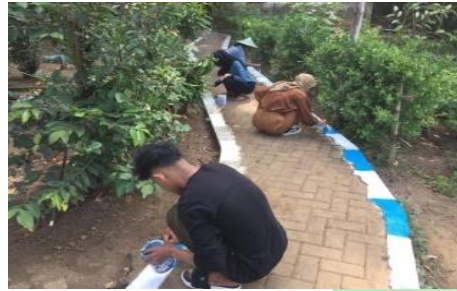
Gambar. 5 Proses pengecatan ulang pembatas jalan
