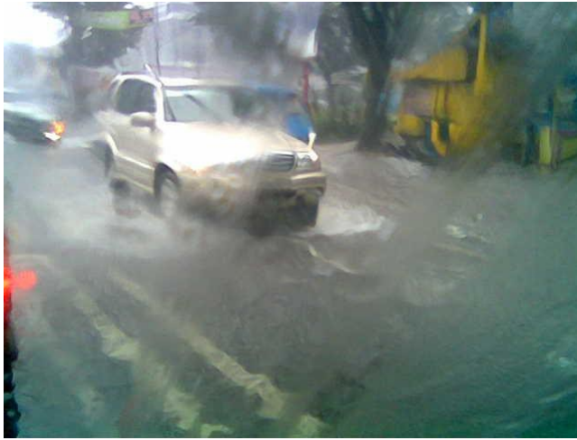
Gambar 2.2 Genangan di jalan tanpa saluran drainase. (Sumber: hasil pengamatan)
