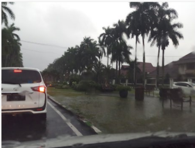
Ijen Boulevard di pertemuan dengan Jl. Semeru Air hujan dari taman melimpas ke jalan
