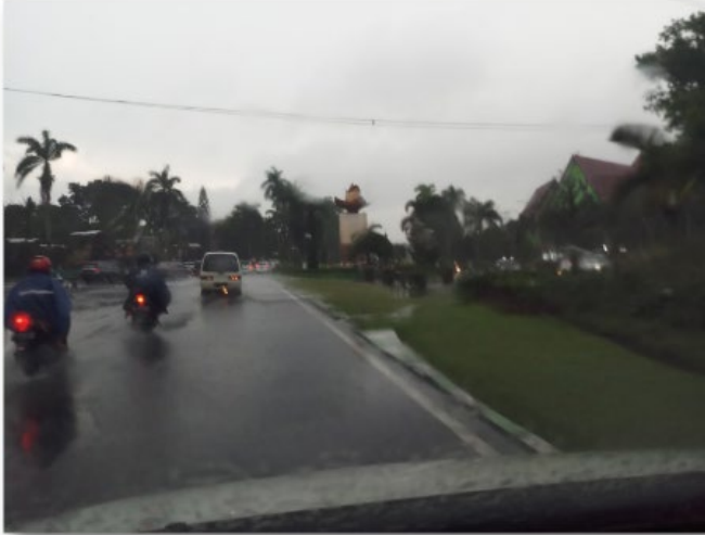
Ijen Boulevard di pertemuan dengan Jl. Wilis Air hujan dari jalan melimpas ke taman. Taman berfungsi untuk menahan air hujan
