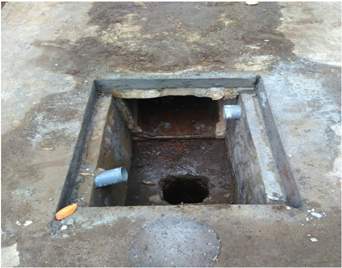
Gambar 6.6 Penampang Atas Sumur Resapan
