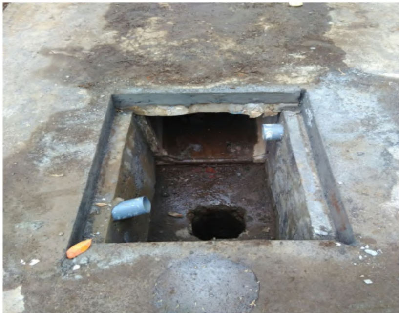
Gambar 6.6 Penampang Atas Sumur Resapan
