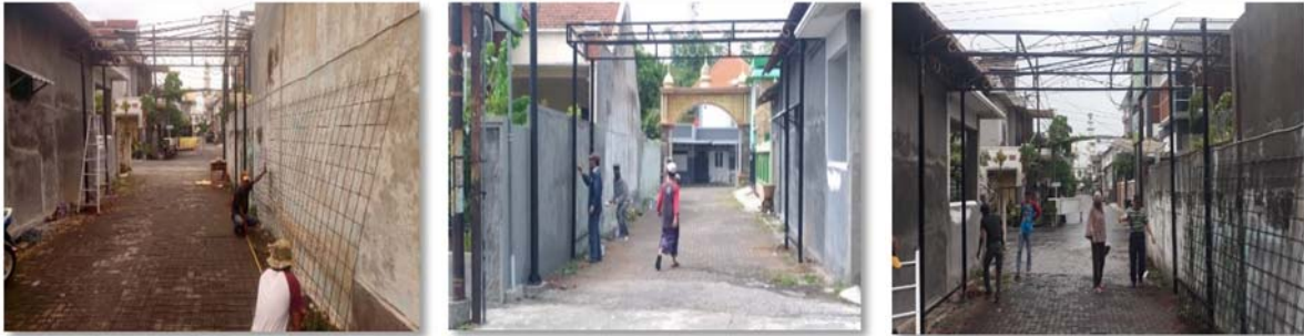
Gambar 5. Proses pengerjaan pemasangan gapura
