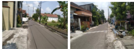
Gambar 1. Pemasangan Polisi Tidur di Jl. Anggrek & Jl. Irawan
