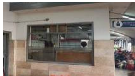
Gambar 15. Penambahan Dinding Marmer.
