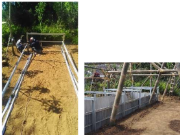
Gambar 5. Instalasi Hidrogranik (6 hari)
