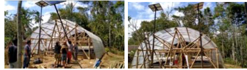
Gambar 6. Instalasi PLTS (2 hari)
