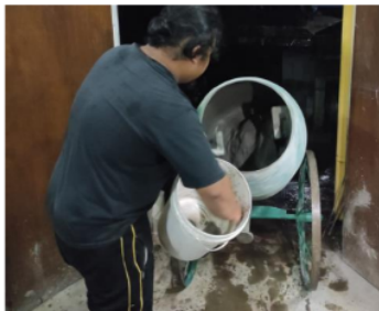
Gambar 4. 3 Memasukan Material Campuran Beton Ke Molen
