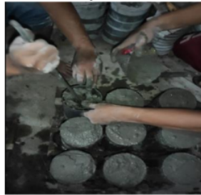
Gambar 4. 14 Pemasangan Campuran Beton Pada Bekisting
