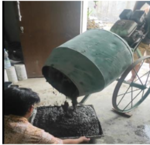
Gambar 4.11 Campuran Beton Dituang Pada Bak
