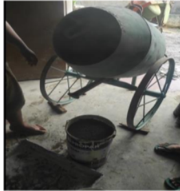
Gambar 4.12 Masukan Material Kedalam Molen
