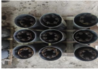
Gambar 4.9 Setting Tulangan Pada Bekisting
