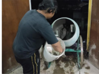
Gambar 4.3 Memasukkan Material Campuran Beton Ke Molen
