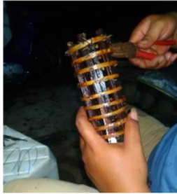
Gambar 4.9 Fabrikasi Tulangan Bambu
