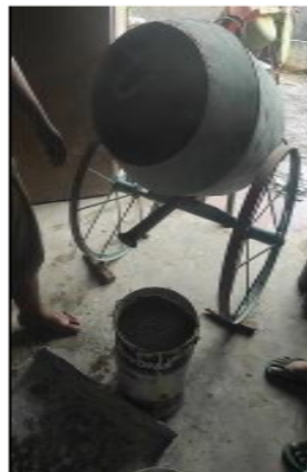
Gambar 4.14 Masukan Material Kedalam Molen
