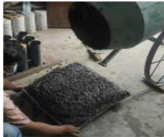
Gambar 4.4 Campuran Beton yang dituang ke Bak
