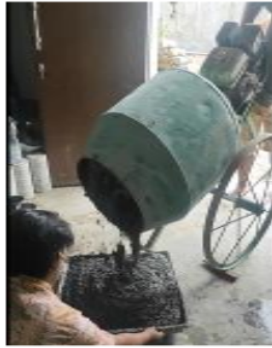
Gambar 4.15 Campuran beton dituang pada bak
