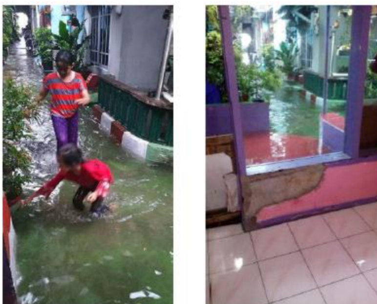
Gambar 2. Kondisi pada waktu kejadian banjir di RT 03
