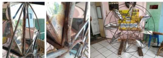
Gambar 10. Tahapan pemasangan sudu ( blade )
