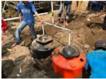
Gambar 12. Pemasangan Alat Biogas.
