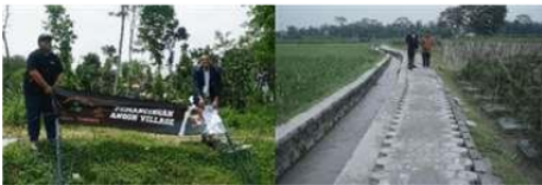
Gambar 1. Pembangunan jalan dan gapura di Embung Pemancingan.
