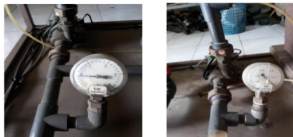
Gambar 3.5 Manometer pompa kiri dan pompa kanan
